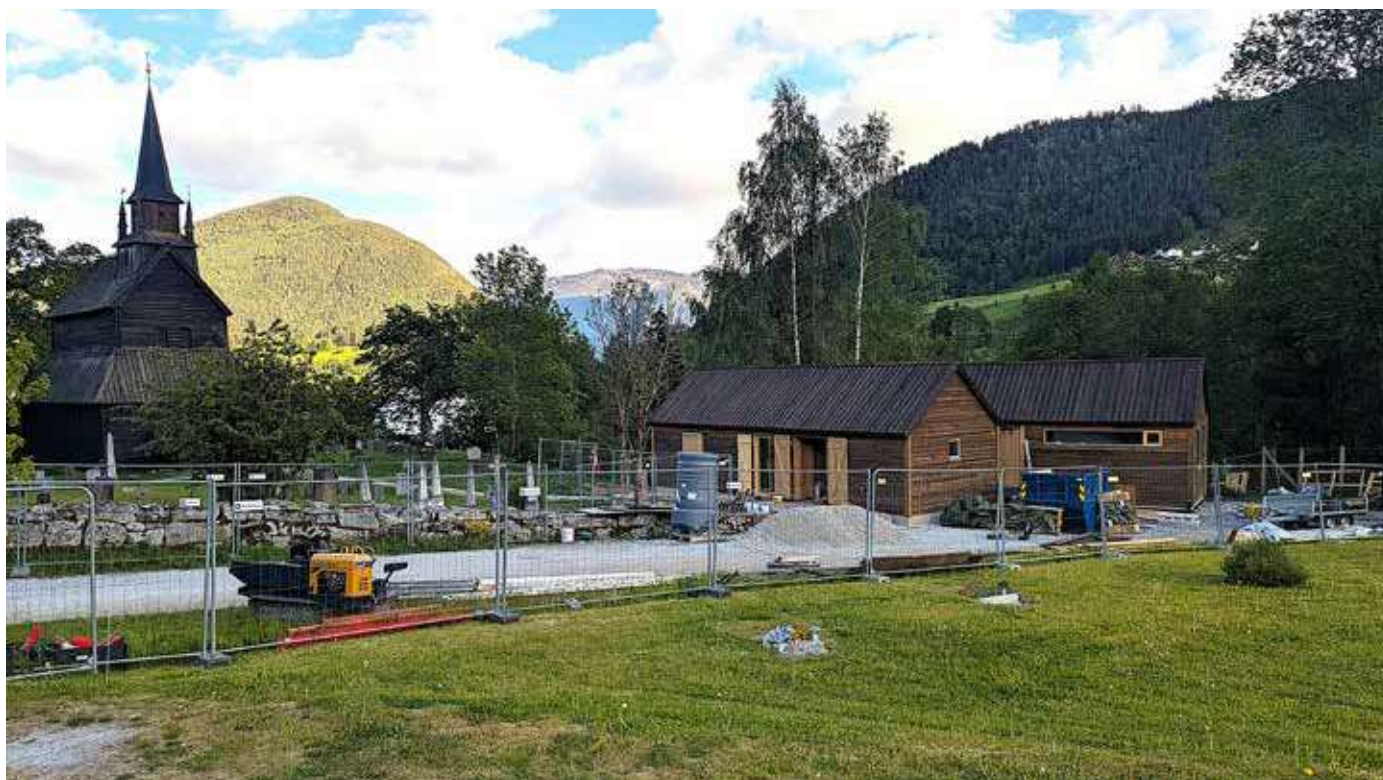
Stavkyrkja er ferdig tjørebreidd, og arbeidet med ny kyrkjestove på Kaupanger nærmar seg slutten. Foto: Hallgeir Øgaard Westli
