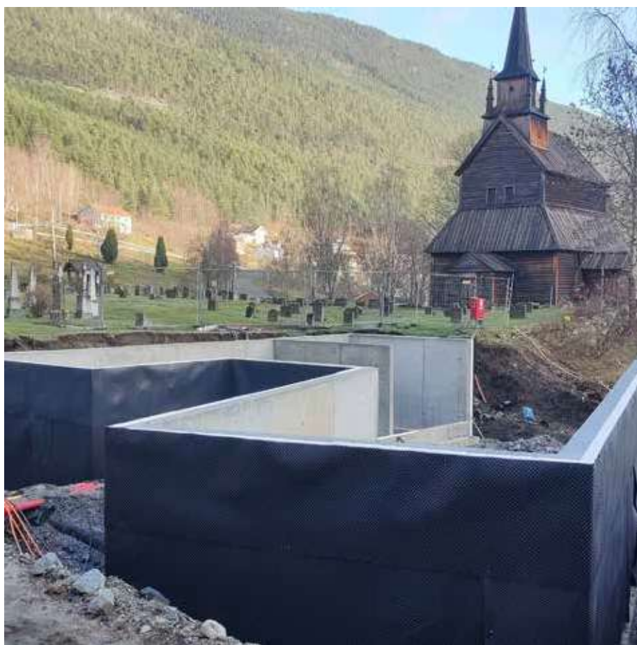
Grunnmuren til det nye kyrkjegardsbygget på Kaupanger er ferdig. Foto: Jostein Risa
