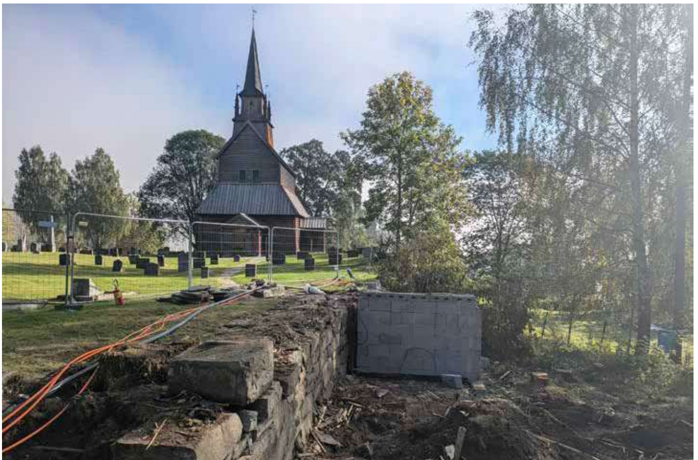
Det gamle kyrkjegardsbygget på Kaupanger er no riven, og arbeidet med ny kyrkjestove er i gang. Foto: Hallgeir Øgaard Westli
