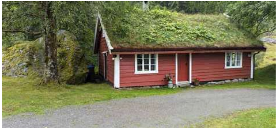
Den lafta gamlestova har fått villmarkspanel og nytt torvtak.
