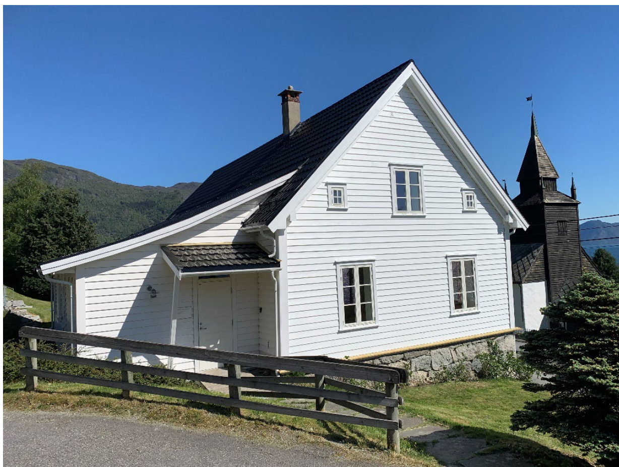
Leikanger kyrkjelydshus, Klokkargarden, med ny kledning og overbygt inngangsparti
